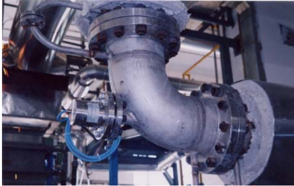
※VA-300 管道安装
